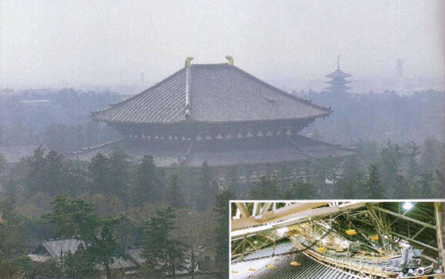
東大寺大仏殿 昭和大修理屋根葺工事 ▶
