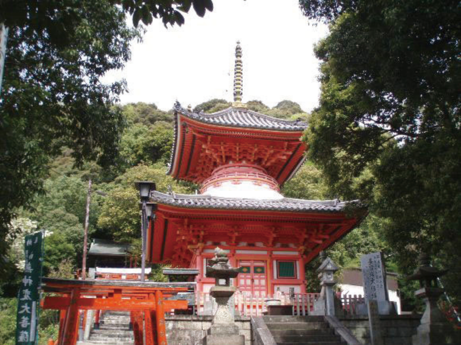
信貴山朝護孫子寺多宝塔 淡路産 いぶし瓦使用
