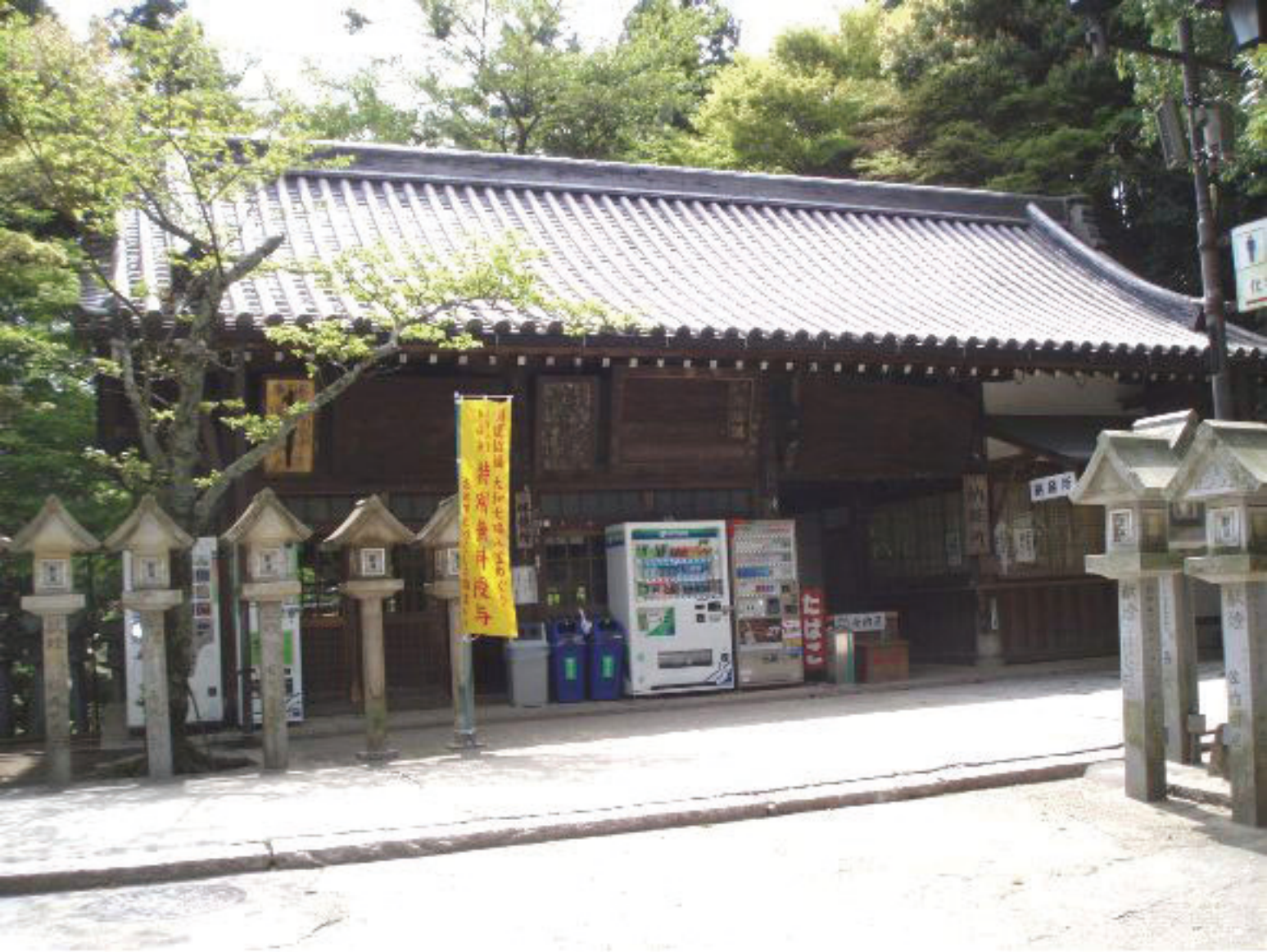
信貴山朝護孫子寺納経所 奈良産 いぶし瓦使用
