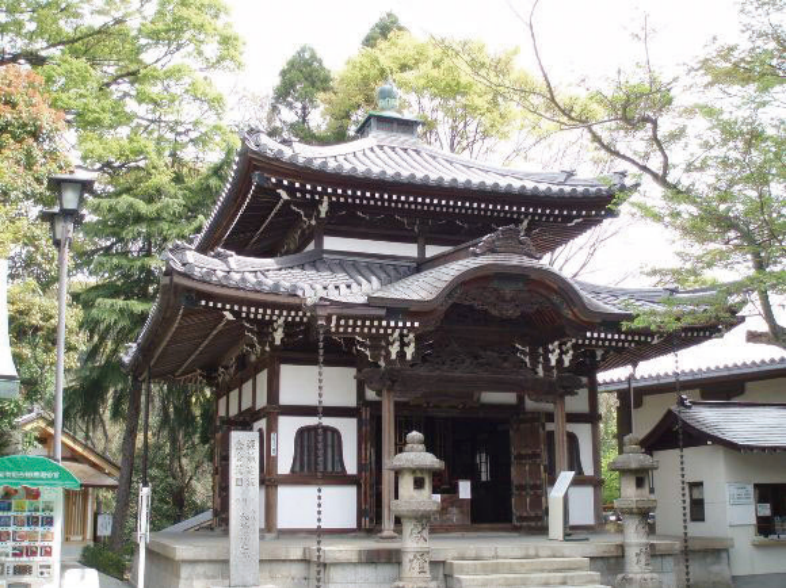
信貴山朝護孫子寺経蔵 奈良産 いぶし瓦使用
