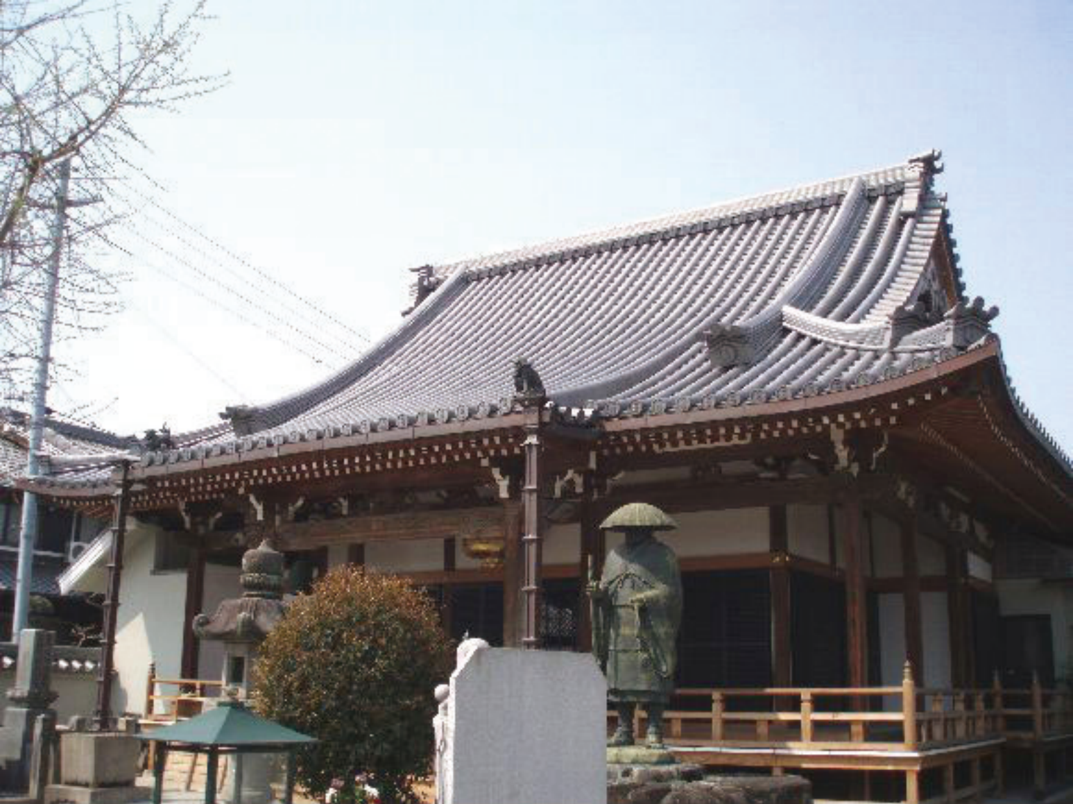
西光寺本堂 奈良産 いぶし瓦使用
