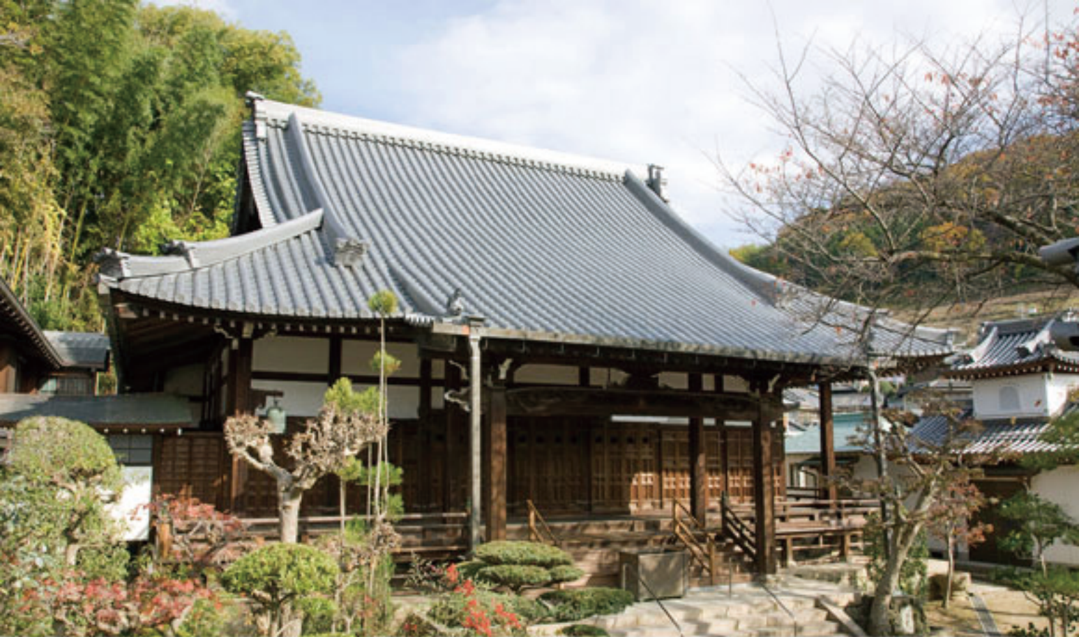
光徳寺 本堂 奈良産 いぶし瓦使用
