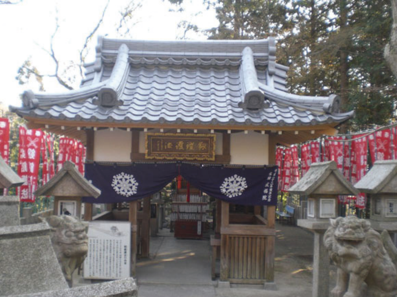
信貴山朝護孫子寺 劔鎧護法堂 奈良産 いぶし瓦使用
