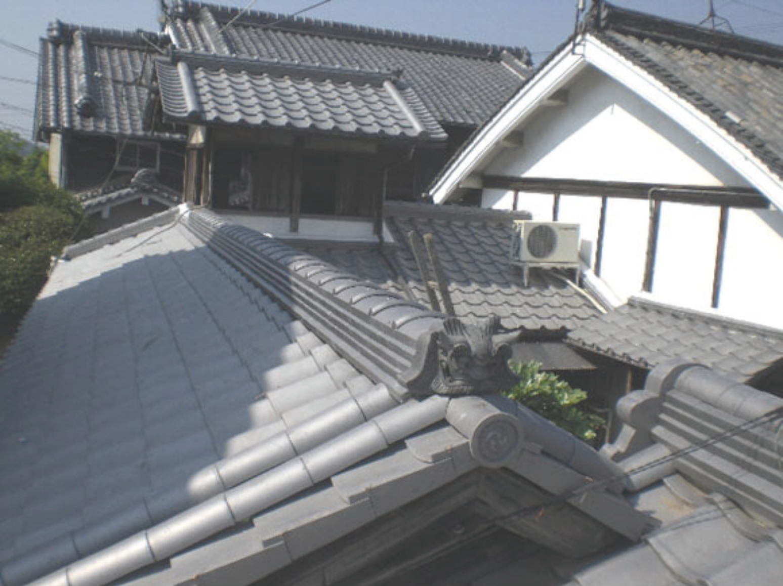
碧陽寺様 庫裡・太鼓楼 淡路産 いぶし瓦使用
