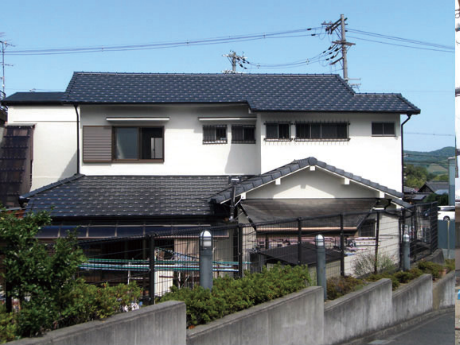
大阪府太子町 S様邸 三州産 平板陶器瓦 (プラウドUU40) 使用
