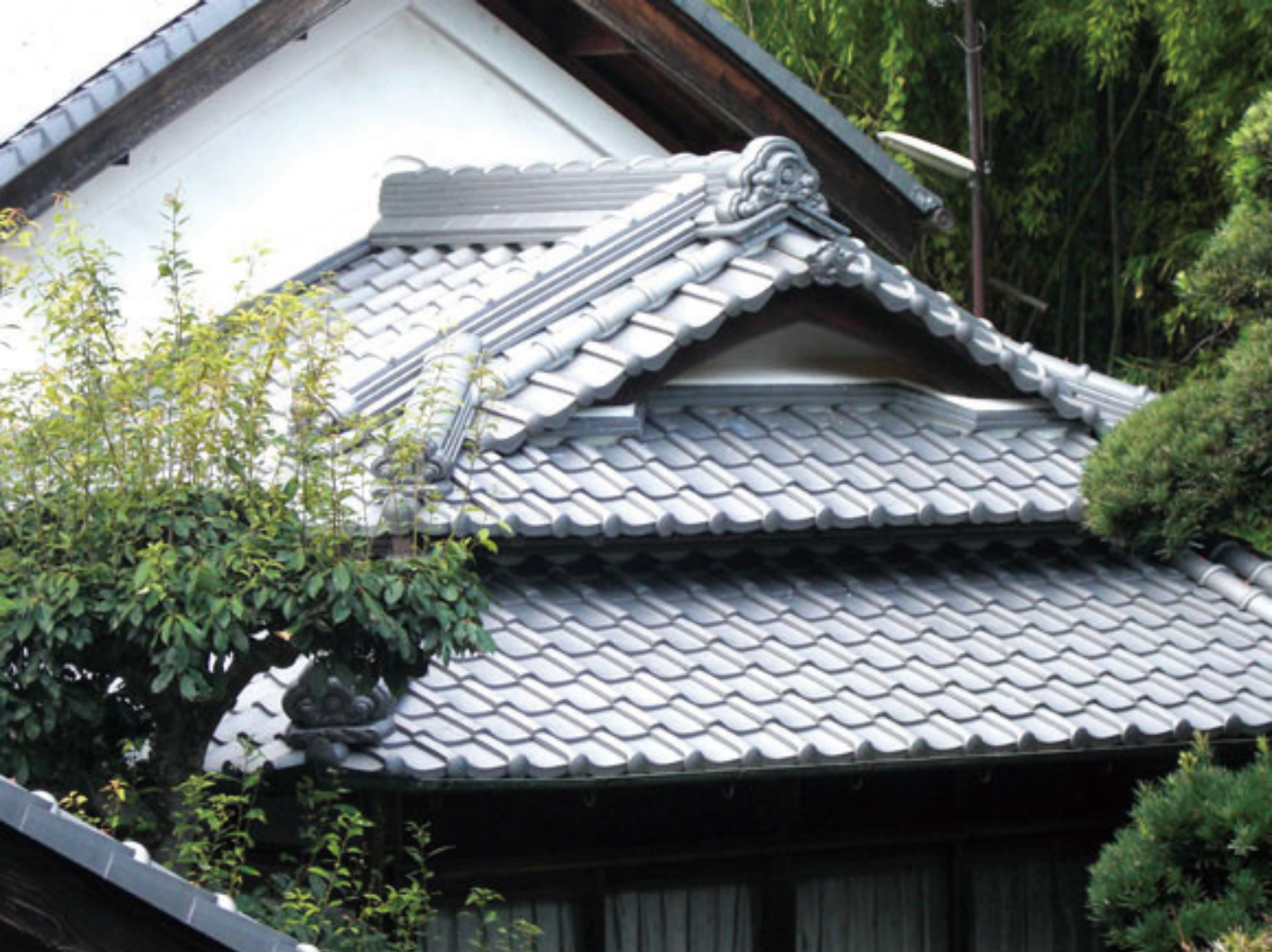
斑鳩町 Y様邸 (離れ座敷) 三州産 いぶし瓦使用
