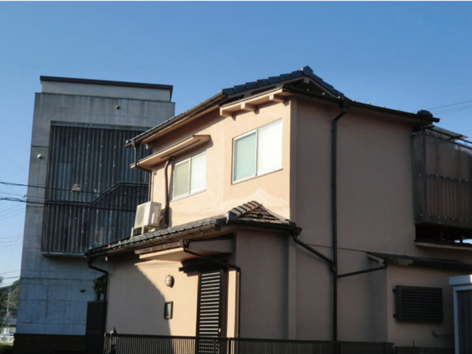
生駒市 O様邸 三州産 平板陶器瓦(スーパートライ タイプI)使用
