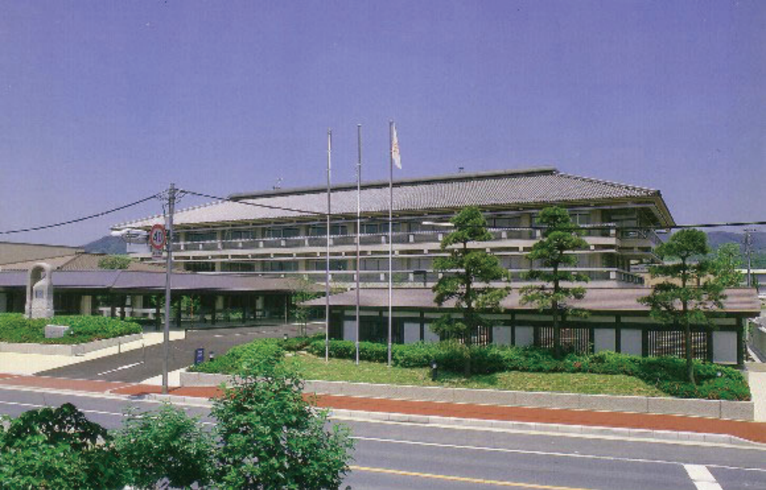
斑鳩町庁舎 奈良産 いぶし瓦使用
