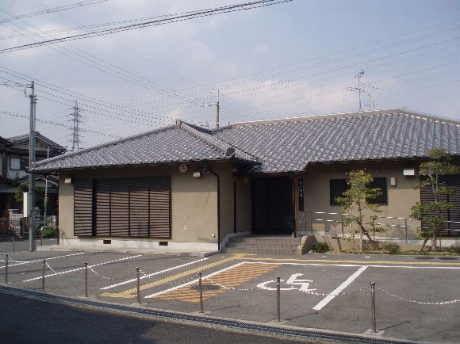
斑鳩昭和町自治会館 淡路産 いぶし瓦使用
