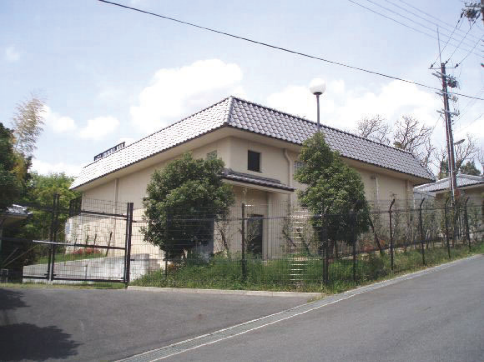
斑鳩町第1浄水場 淡路産 いぶし瓦使用
