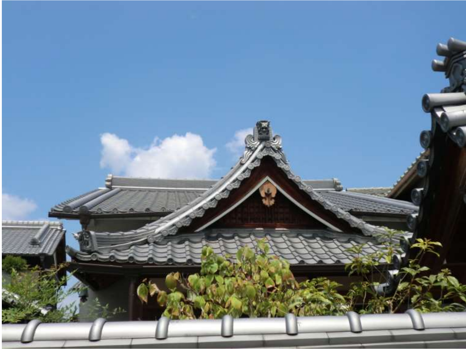
養福寺 本堂 淡路産 いぶし瓦使用
