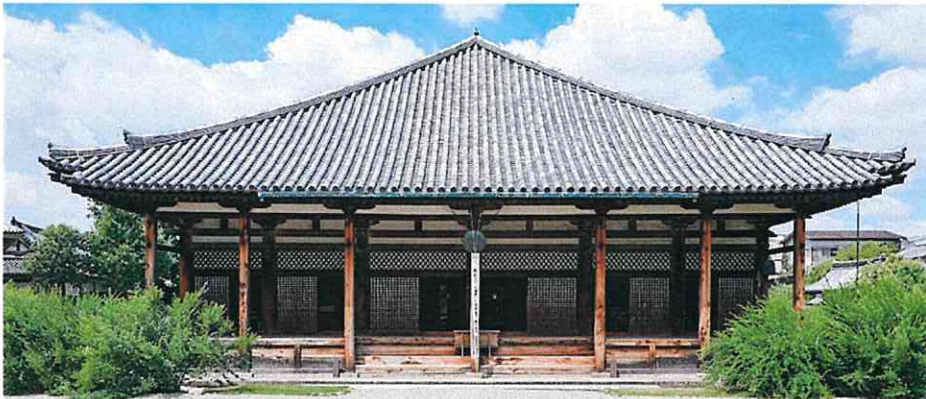
左側は本瓦葺き、右側は行基葺き
