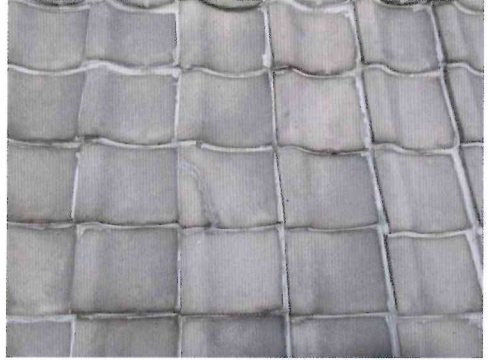
4 辺全て、もれなく塗られた例 この施工がされた屋根は、ほとんどの案件が中で雨漏りが起きています。
