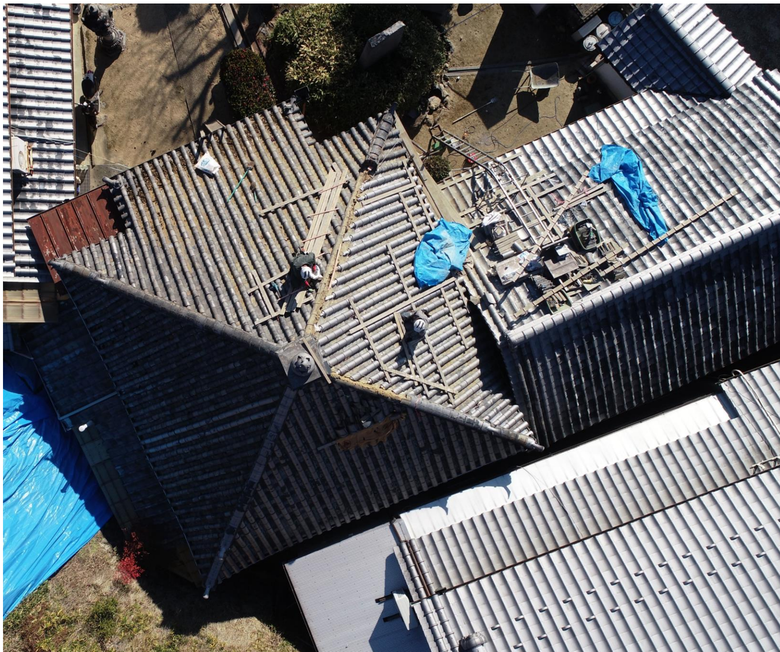
子安地蔵院 本堂 修理工事
