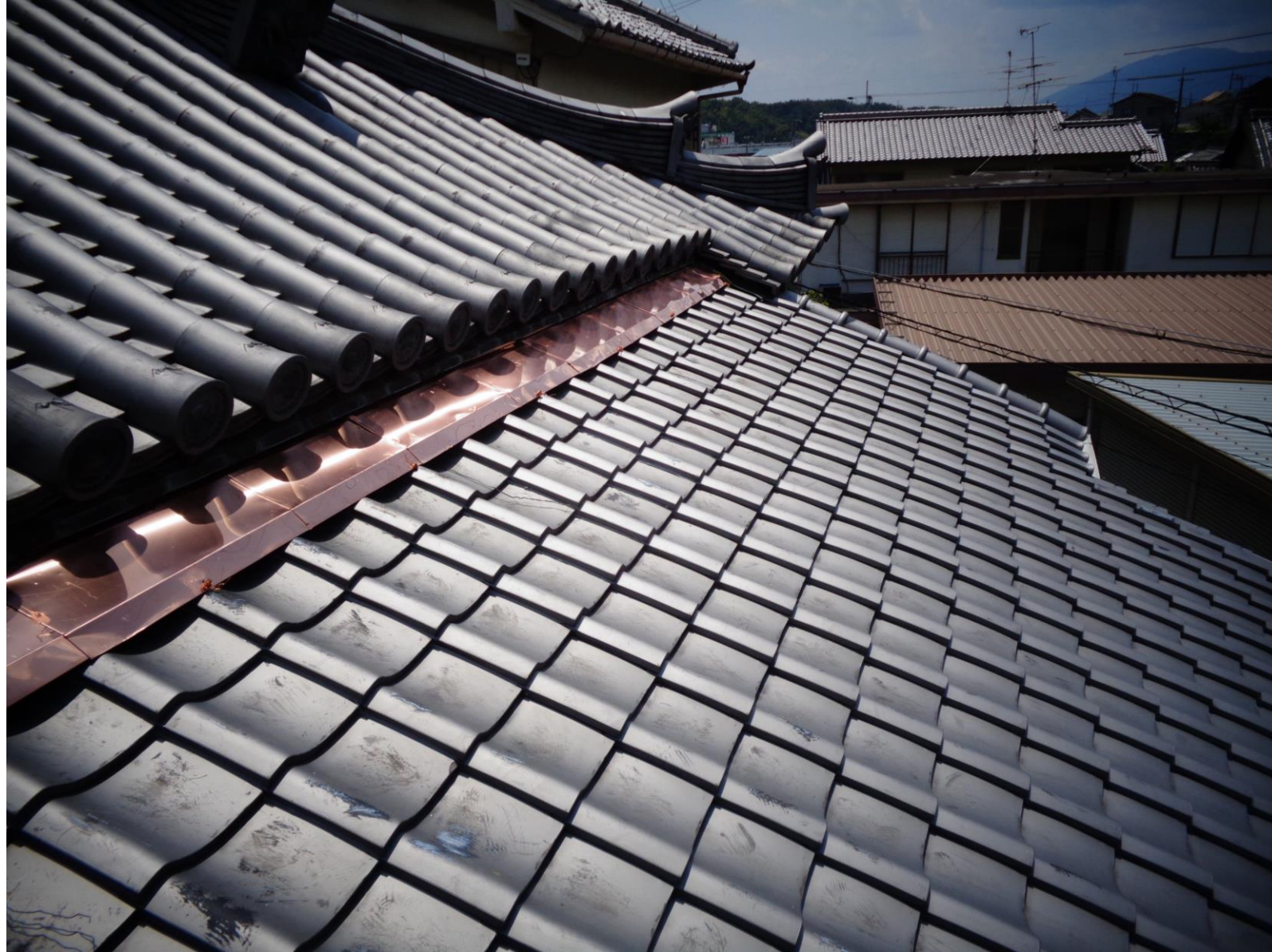
碧陽寺 本堂 修理工事
