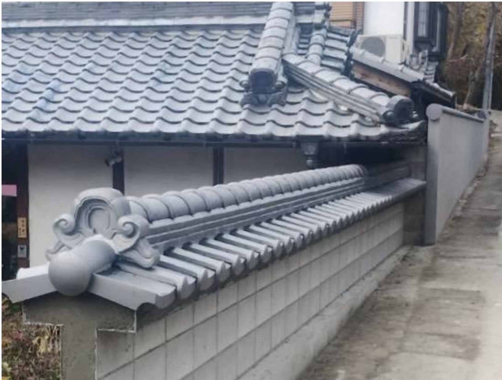
生駒郡平群町 N様邸 塀新築工事
