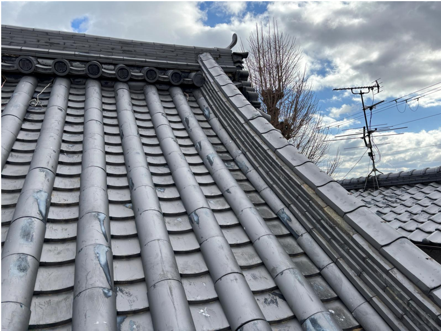
順教寺 本堂修理工事 三州産瓦使用
