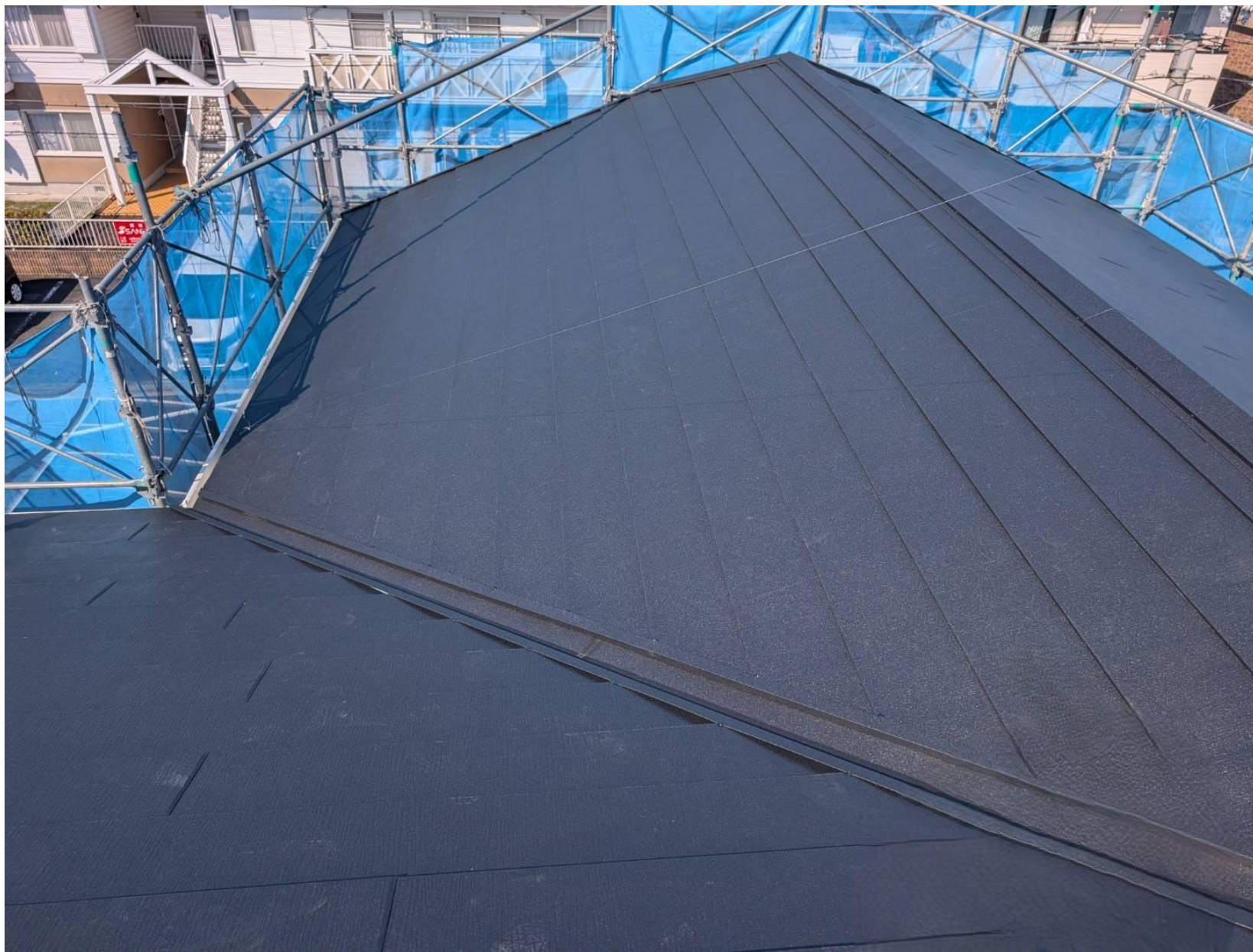
広陵町 S様邸 屋根葺き替え工事 カバー工法
