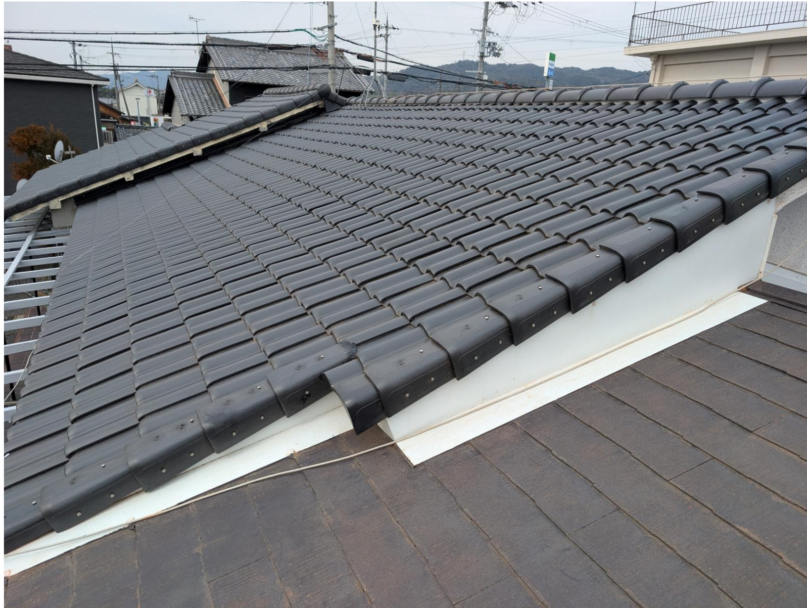
斑鳩町 N様邸 葺き替え工事 朝日窯業AMⅡ使用
