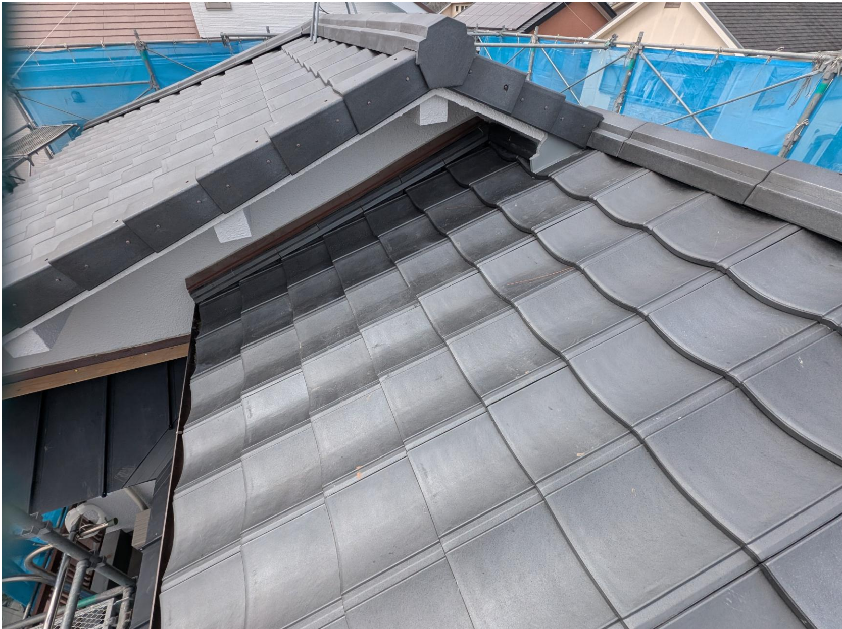
香芝市 O様邸 葺き替え工事 ROOGA雅使用
